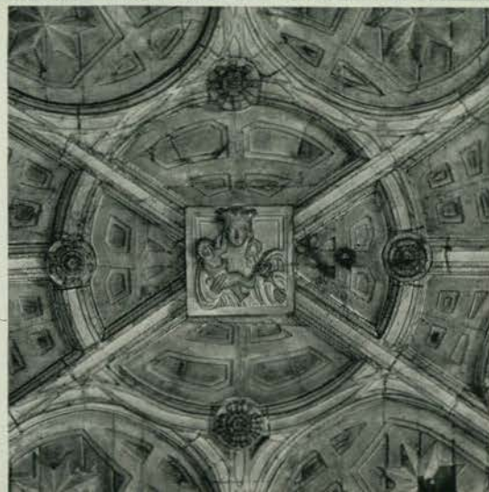
34 y 35 - ELVILLAR. - Bóveda de la parte posterior del templo.
