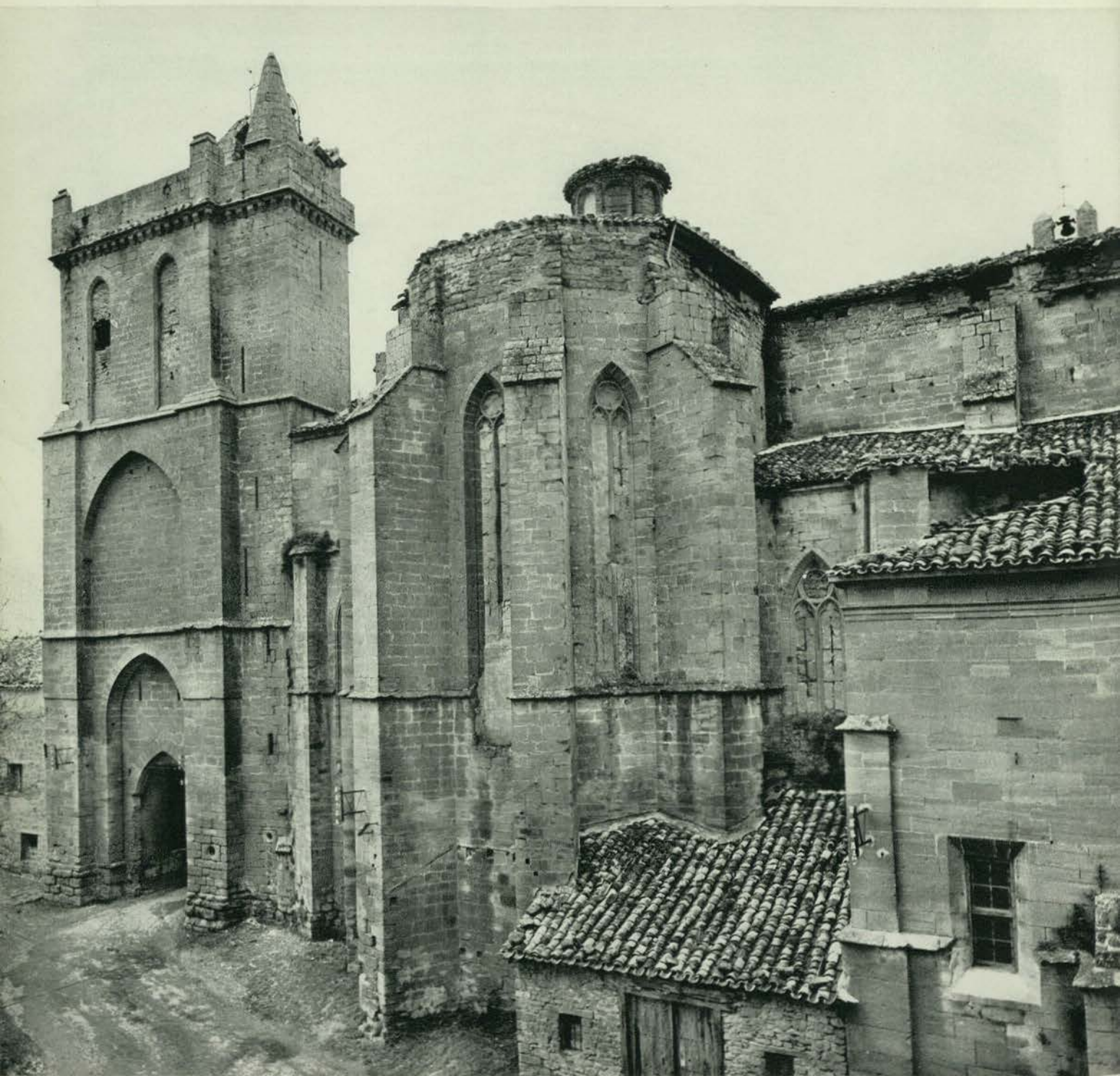
93 - LAGUARDIA. - San Juan. Torre y ábsides.
